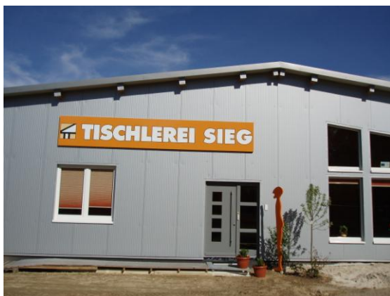
Abb. 13: Unternehmensförderprogramm des Landkreises Stade – gefördertes Betriebsgebäude der Tischlerei Sieg in Buxtehude-Ottensen; Quelle: Foto Wirtschaftsförderung
